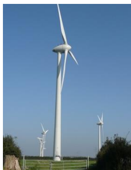
Parc éolien de Nibas 1
